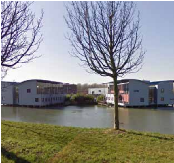
Voorveste in Houten laat creatief ruimtegebruik op het water zien.
